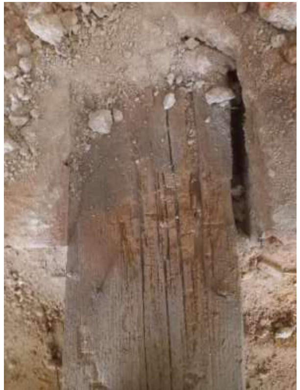
Foto. – HP, rozpad dřeva (M16), 3.NP
