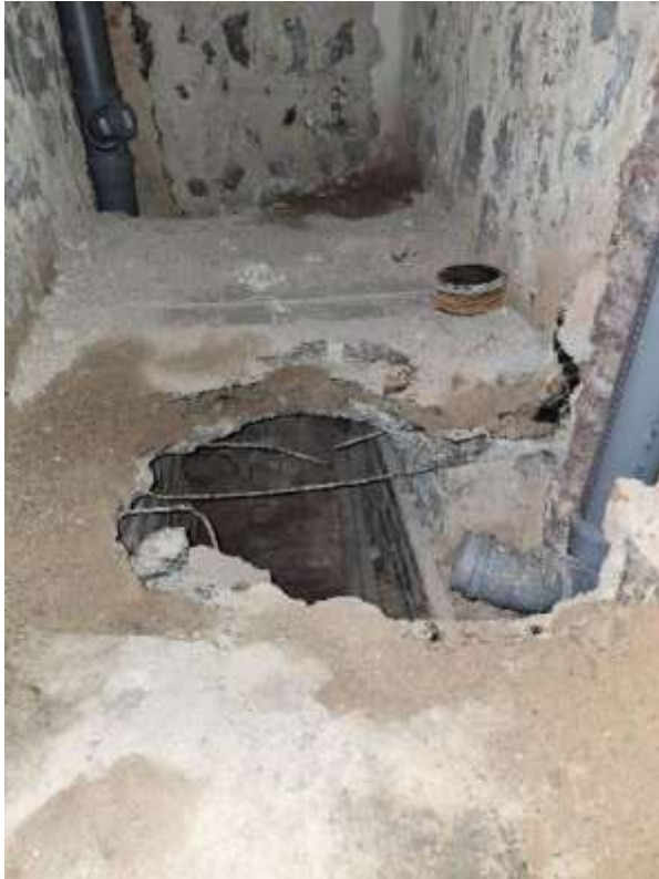
Foto – ŽB strop 2.PP
