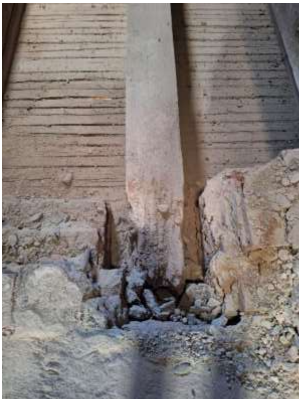
Foto. – HP, stropní trám nad 5.NP
