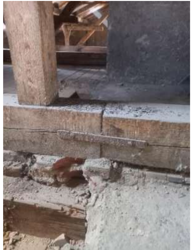
Foto. – Spoj vazného trámu
