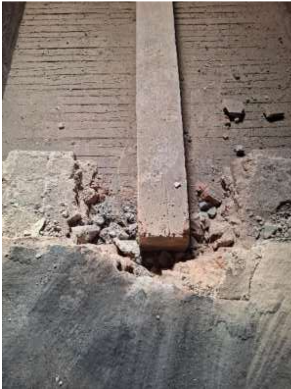
Foto. – PP, stropní trám nad 5.NP
