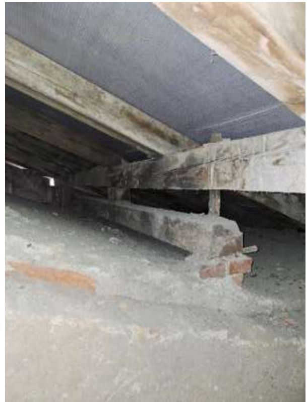
Foto. – PP, Výměna nad schodištěm
