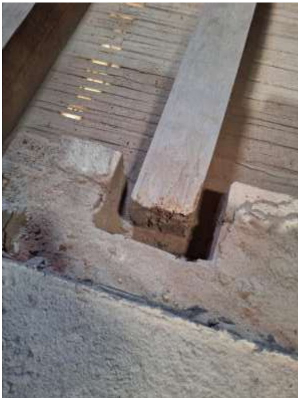
Foto. – HP, stropní trám nad 5.NP
