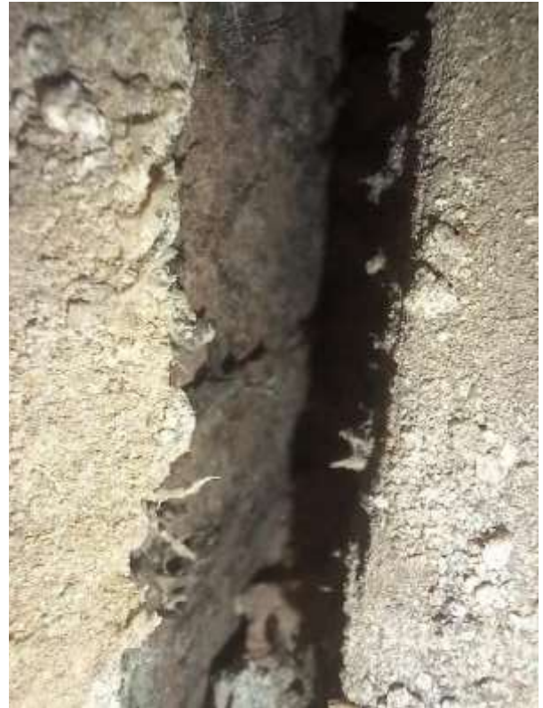
Foto. – aktivní mycelium v zhlaví (M16), 3.NP
