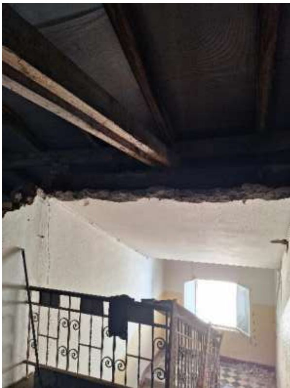
Foto. – Strop nad schodištěm
